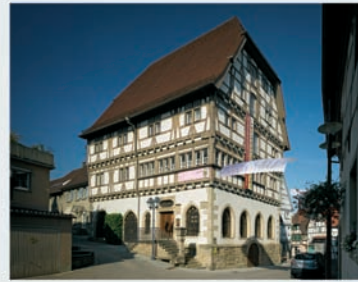
1495 Alte Universität Eppingen, Altstadtstraße Das prächtige, fast 23 Meter hohe Gebäude zählt zu den schönsten Gebäuden von Eppingens Altstadt. Über einen massiven Erdgeschossbau des 15. Jahrhunderts erhebt sich der weite Geschossbau des 16. Jahrhunderts. Das Innere umschließt einen Hofraum seinem Erdgeschoss von 1544. In diesem und im folgenden Jahr waren wegen einer Pestepidemie hier Heilbrunnler Studenten untergebracht.
