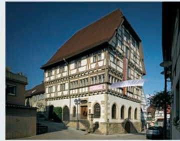
1495 Alte Universität Eppingen, Altstadtstraße Das prächtige, fast 23 Meter hohe Gebäude zählt zu den schönsten Gebäuden von Eppingens Altstadt. Über einem massiven Erdgeschoss aus Sandstein erhebt sich vier weitere Geschosse aus zierlichen Fachwerk. Das Haus umschließt einen Hofraum seinem Eingang von 1544. In diesem und im folgenden Jahr waren gegen einen Protestantenführer Heilbronner Studenten untergebracht.
