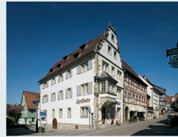
1550 Apothekengebäude Gundelshausen, Schlossstraße Gundelshausen gehörte zu dem Deutschen Orden. Der Teil am westlichen Ende des Ortes ein Spital gründeten. Bedeutend übernahm davon ist die Apotheke St. Elisabeth, ein wichtiger dreigeschossiger Steinbau mit aufwendigen Ecker und den für jene Zeit typischer Holzangestrichen.
