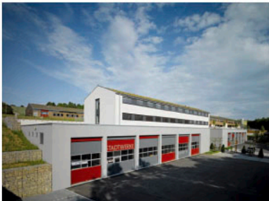
2012 Bauhof und Stadtwerke der Stadt Neckarsulm Am Hungerberg
