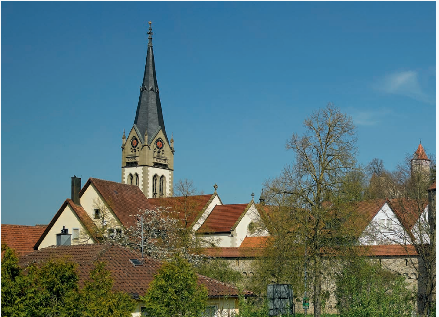
Möckmühl, Stadtmauer und Turm der Stadtpfarrkirche
