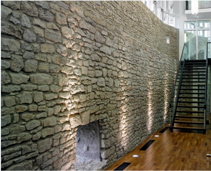
Mittelalter trifft Moderne. Die historische Stadtmauer im Inneren des Bankgebäudes der Volksbank Möckmühl-Neuenstadt eG.
