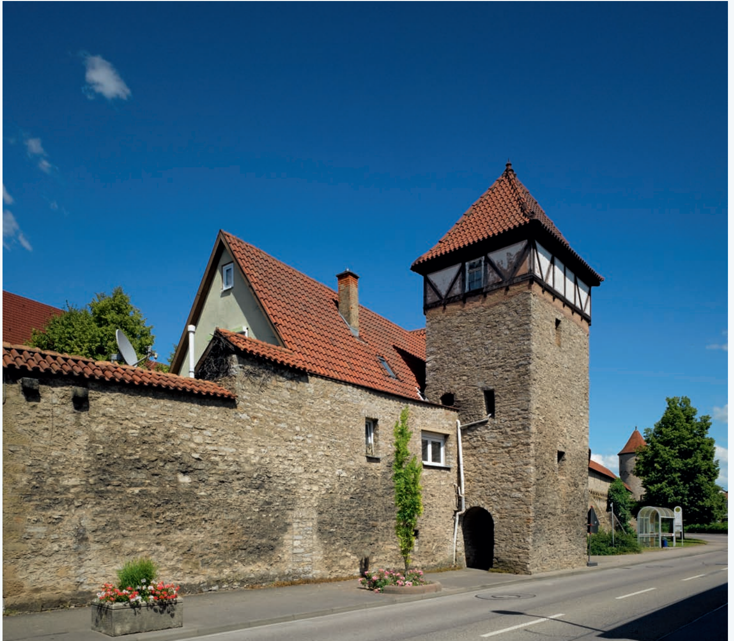
Möckmühl, Stadtmauer mit Badturm
